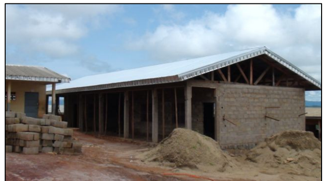
De computerruimte alias resource-room in aanbouw
